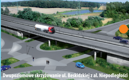
Dwupoziomowe skrzyżowanie ul. Beskidzkiej z al. Niepodległości
