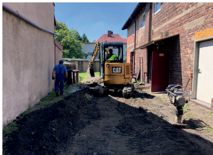
Wymiana przyłączy do budynku przy ul. Miodowej 6
