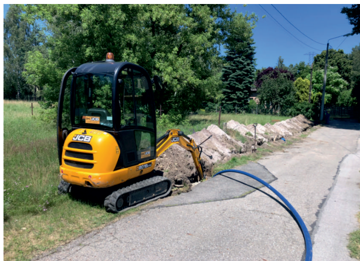
Wymiana przyłączy do budynków przy ul. Karłowicza 1 i 2
